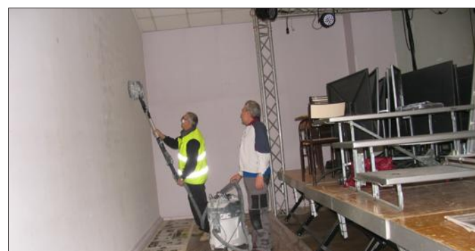
Les ouvriers communaux et les bénévoles sont à l'œuvre. Photo RL
