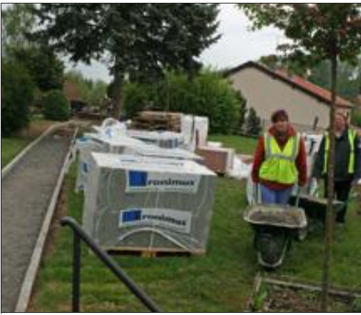
La réfection des allées du cimetière avance train.
