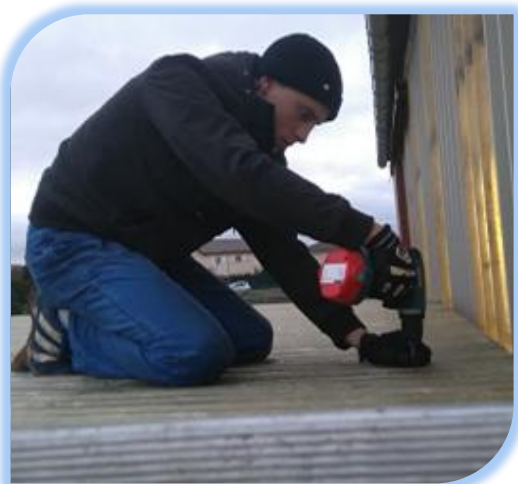
Jordan répare le toit du club-house après un gros coup de vent. Le Bricoleur de Sauv'Equi ! Qui veut venir l'épauler ?
